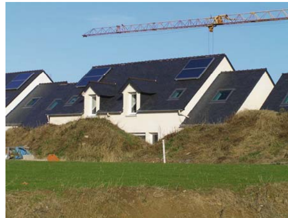
Une approche environnementale des nouvelles constructions. Ici, la mise en place de panneaux solaires dans un lotissement communal
