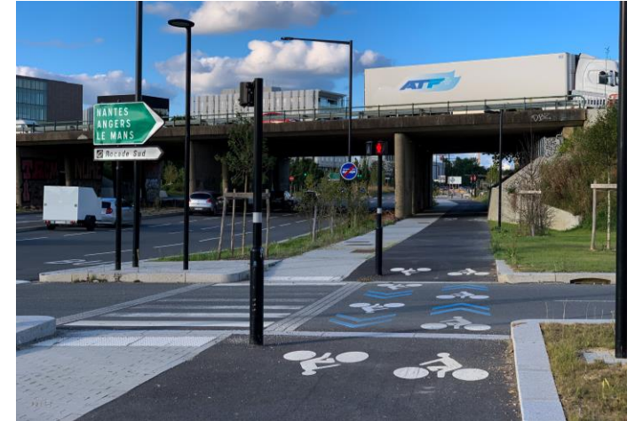
Marquage renforcé à l'intersection de piste à Rennes
