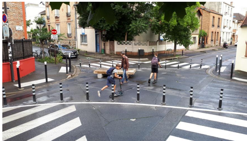
Fermeture d'un carrefour à la circulation motorisée, porosité avec les modes actifs, Montreuil (93). Photo : Paris en Selle
