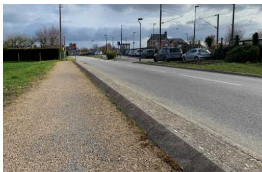
Piste cyclable séparée par un séparateur chanfreiné
